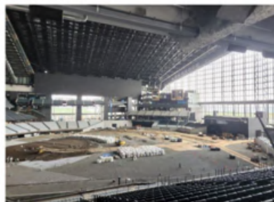
天然芝工事中の状況
